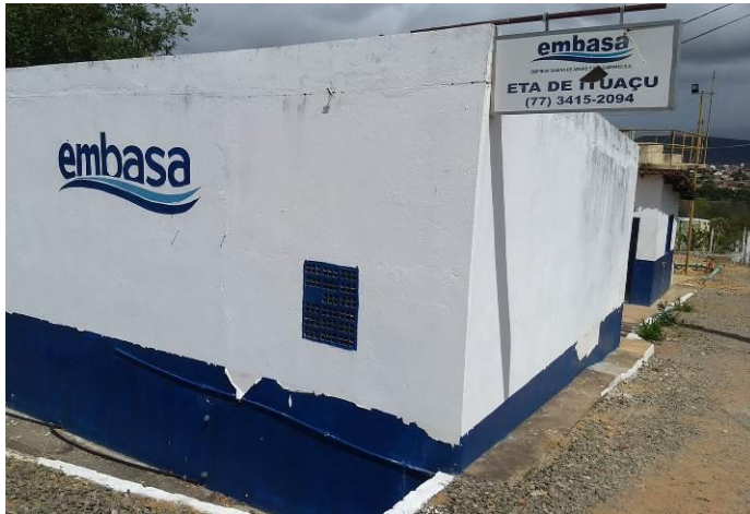
Foto 21 – Estação de Tratamento de Água - ETA
